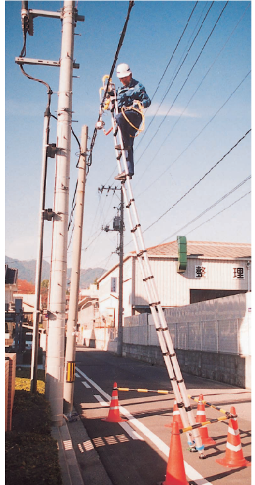
▲最長5.6mまで伸ばしての ケーブル作業風景
